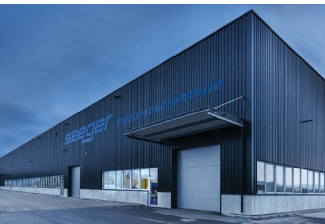
Seeger Präzisionsdrehteile (precision turned parts) GmbH, Salem-Neufrach | DE Architects: Planquadrat Gaiser & Partner MBB, Sigmaringen | DE Electrical contractor: Planungsbüro Fiegl, Baienfurt | DE Electrical installation: Schwägler Elektrosysteme e.K., Frickingen | DE
