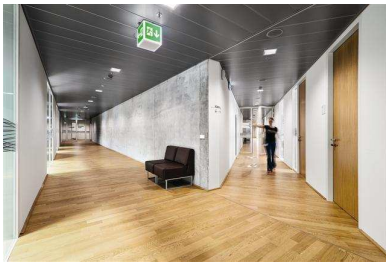
Bild 4: Eine gleichmäßige Grundbeleuchtung in den Gängen des Verwaltungsbereichs liefern die Downlights Panos Q. Die LED-Rettungszeichenleuchte Cubesign weist den Fluchtweg.
